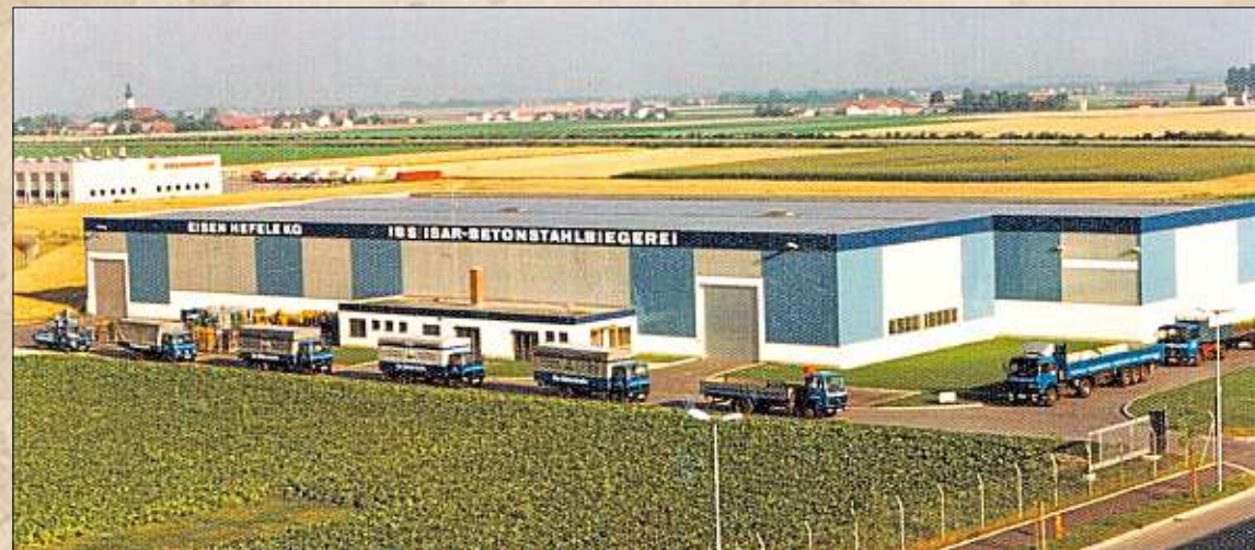
1983 eröffnete die IBS Isar-Betonstahlbiegerei an der Robert-Bosch-Straße im Industriegebiet.
